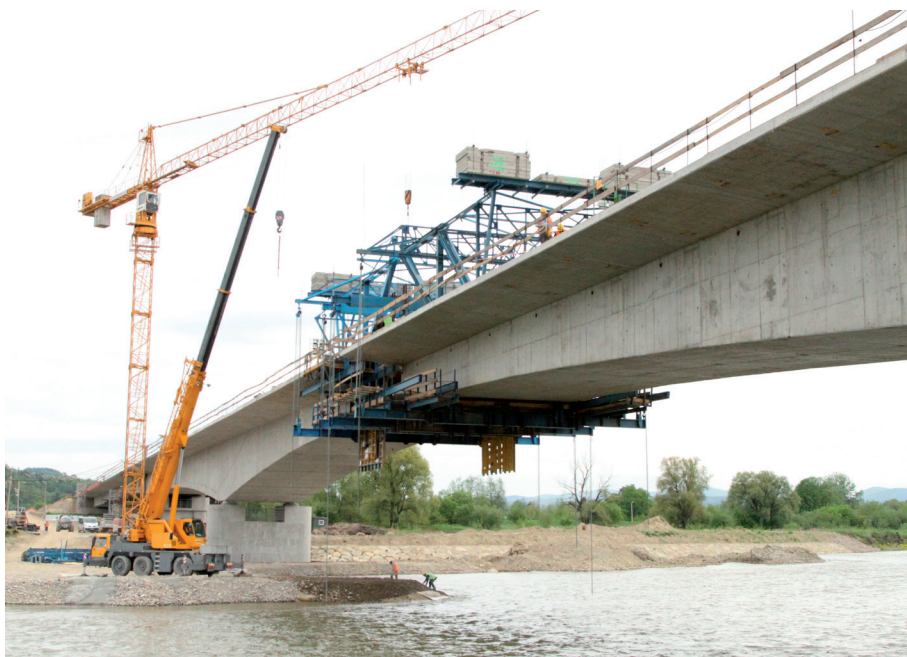
Obwodnica Północna Nowego Sącza w budowie
