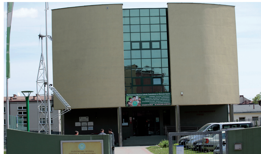
Siedziba Instytutu Technicznego PWSZ w Nowym Sączu
